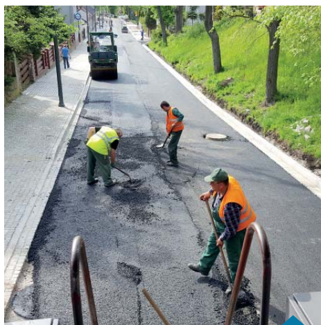
W trakcie prac 17 maja br.
