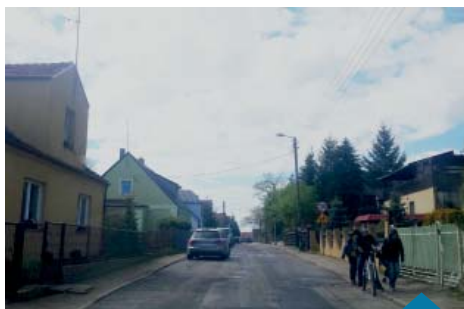
Ul. Szkolna przed przebudową.
